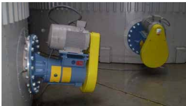
Миксеры Plenty с фиксированным углом и ременным приводом, установленные на греющей емкости
